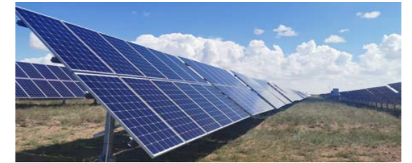
援建光伏村级电站
