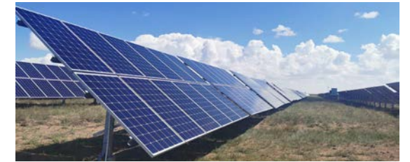
援建光伏村级电站
